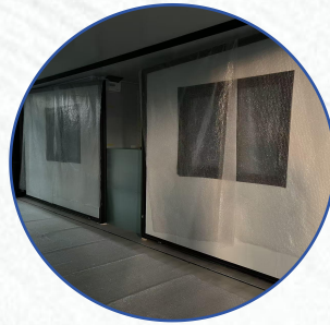
墙壁和地板铺泡沫
