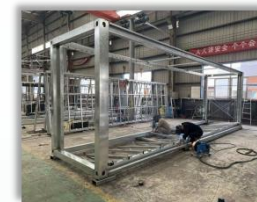
主框架拼装焊接
