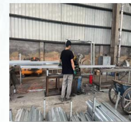
切割镀锌方管
